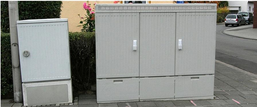
Abbildung 284: Kabelverzweiger (links), Outdoor-DSLAM (rechts) (Wikimedia Commons)
